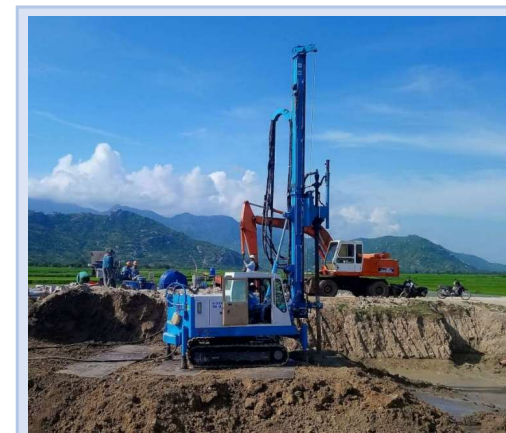
チュン・ナム 風力太陽光発電（基礎工事）
